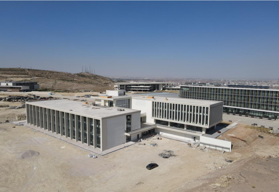
Resim 5: Nezahat Keleşoğlu Sağlık Bilimleri Fakülte İnşaatı Önü Hafriyat Kazı İşi
