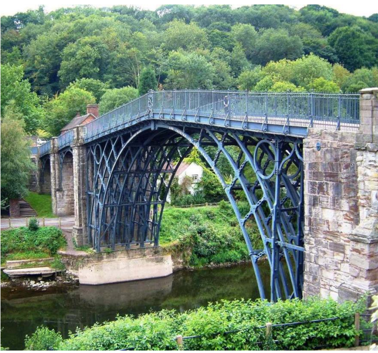
Kemerli formda yapılmış ilk metal köprü
