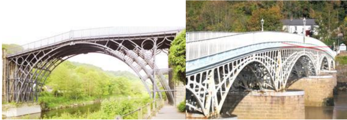
Dökme Çelikten Yapılan Kafes Sistemli Kemer Köprüler
