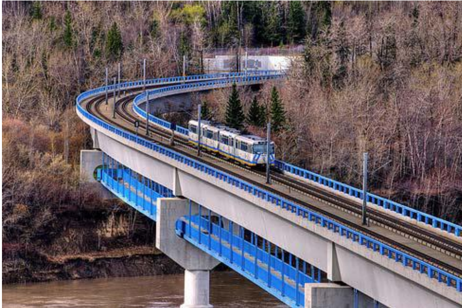
Alt kısmı yayalar üst kısmı ise demiryolu için tasarlanmış bir köprü
