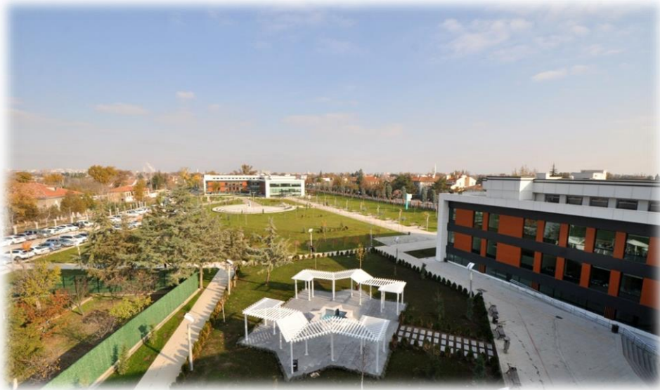
Resim-8: 15 Temmuz Kampüsü Rektörlük Binası Onarımı
