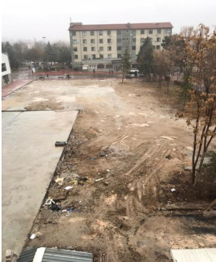
Resim-6 : Hastane eski blokları yıkım ve onarım işleri
