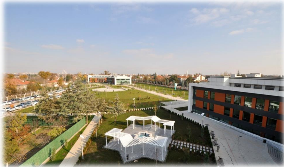
Resim-7: 15 Temmuz Kampüsü Rektörlük Binası Onarımı
