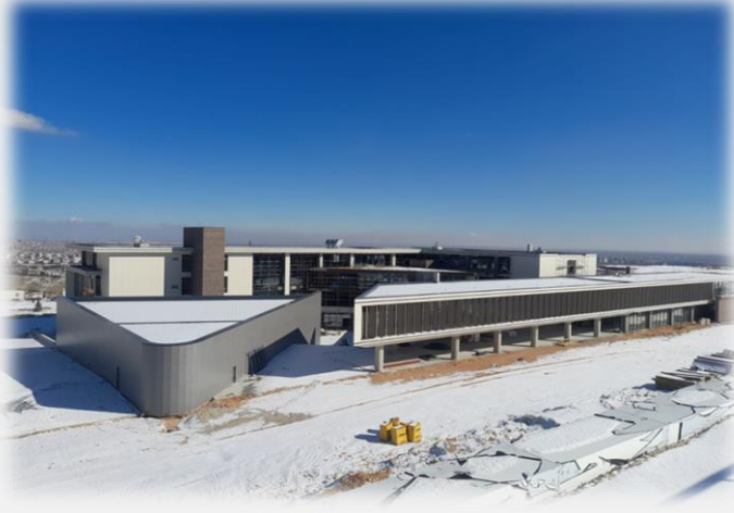
Resim-1, 2: Mühendislik Mimarlık Fakültesi İdari ve Derslik Blokları
